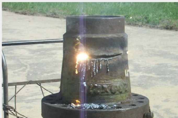
Лазерная резка арматуры
