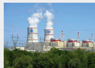
Фрагментация оборудования на АЭС
