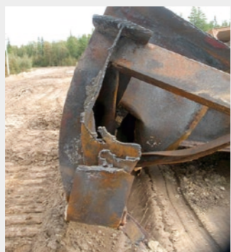
Примеры лазерной резки конструкций объектов, разрушенных при аварии на газовой скважине.
